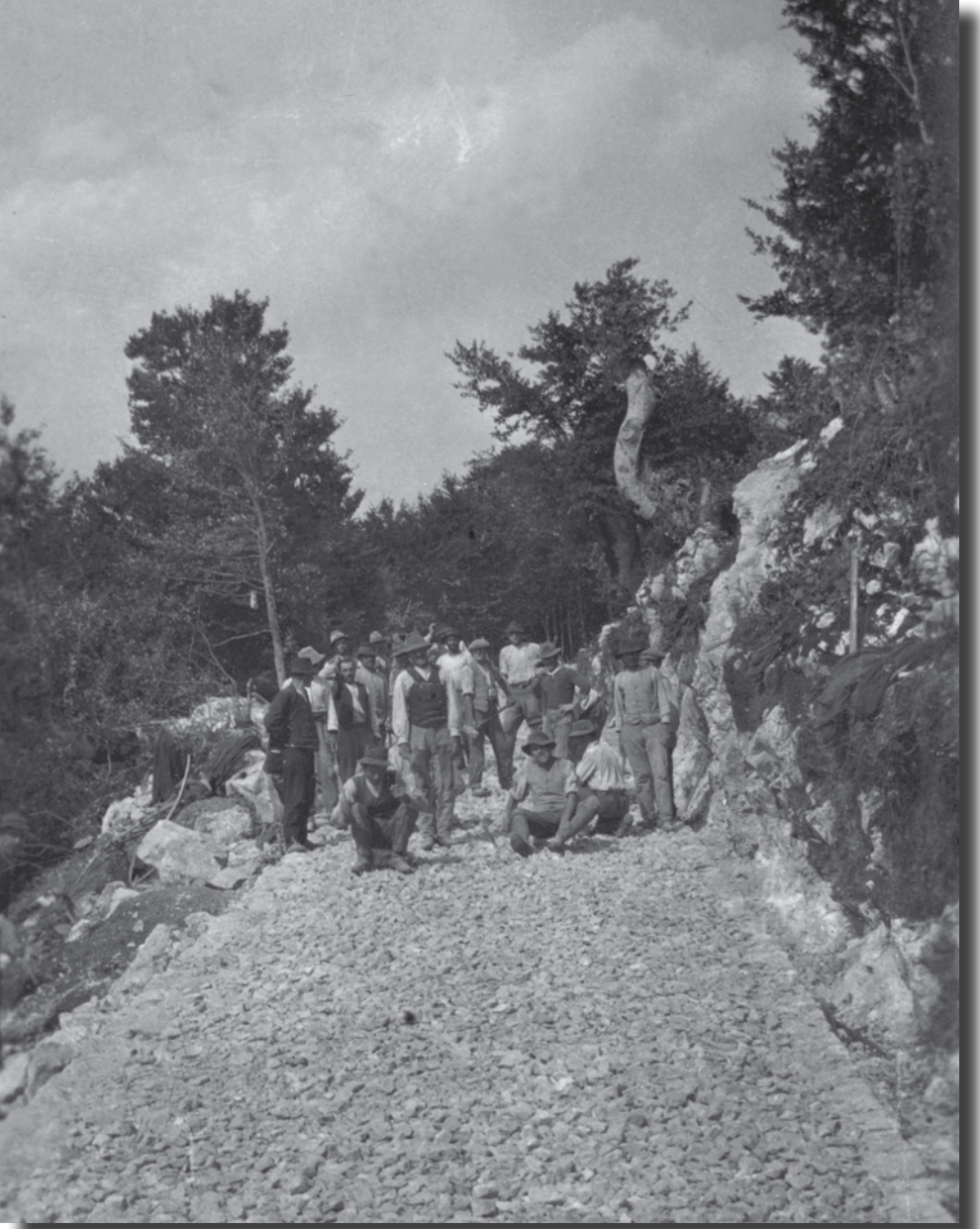
Operai in posa dopo aver terminato una strada. [PS2-089]
