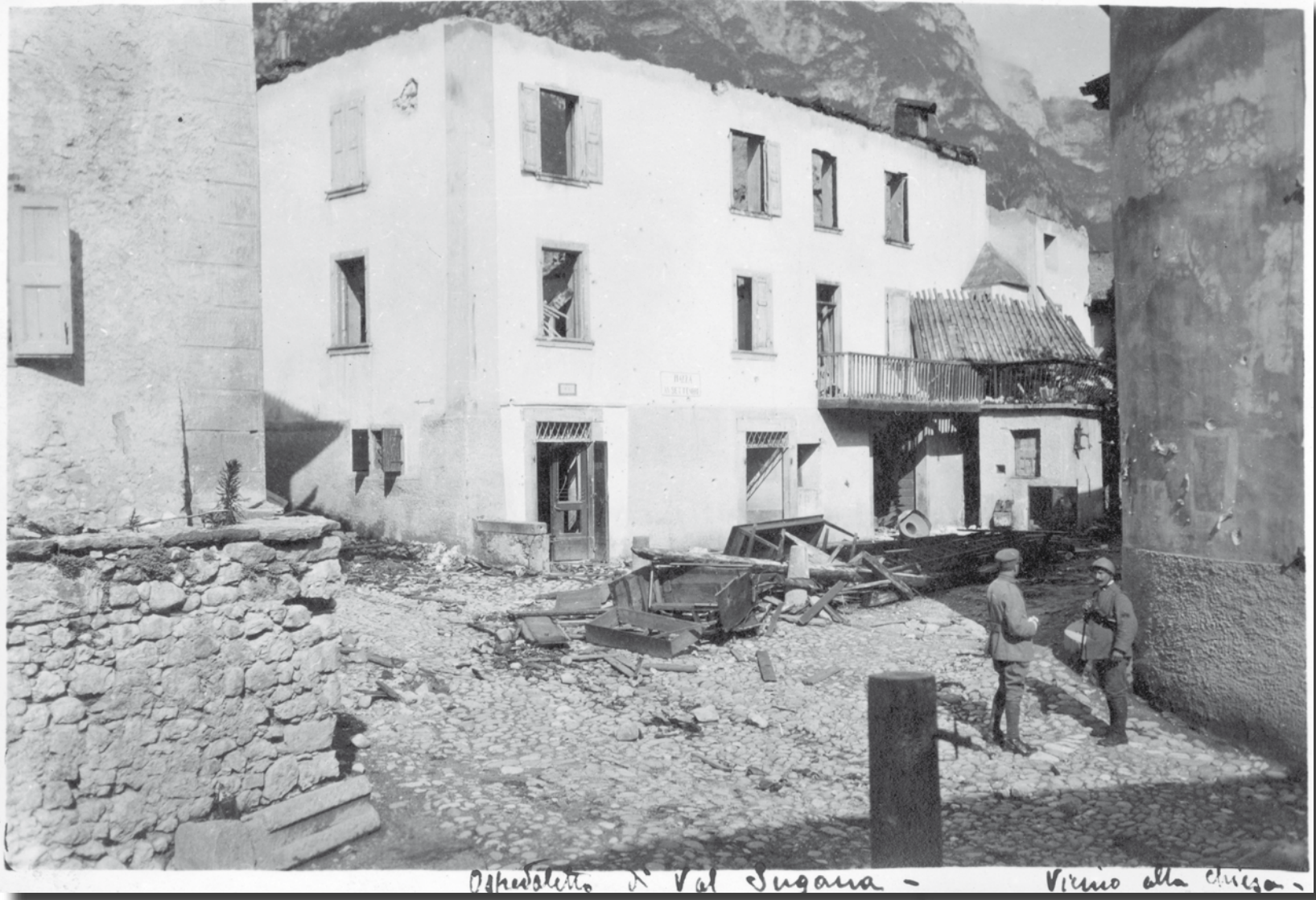
Ospedaletto (TN), giugno 1916. Il centro storico del paese danneggiato dai combattimenti. [PS6-091]
