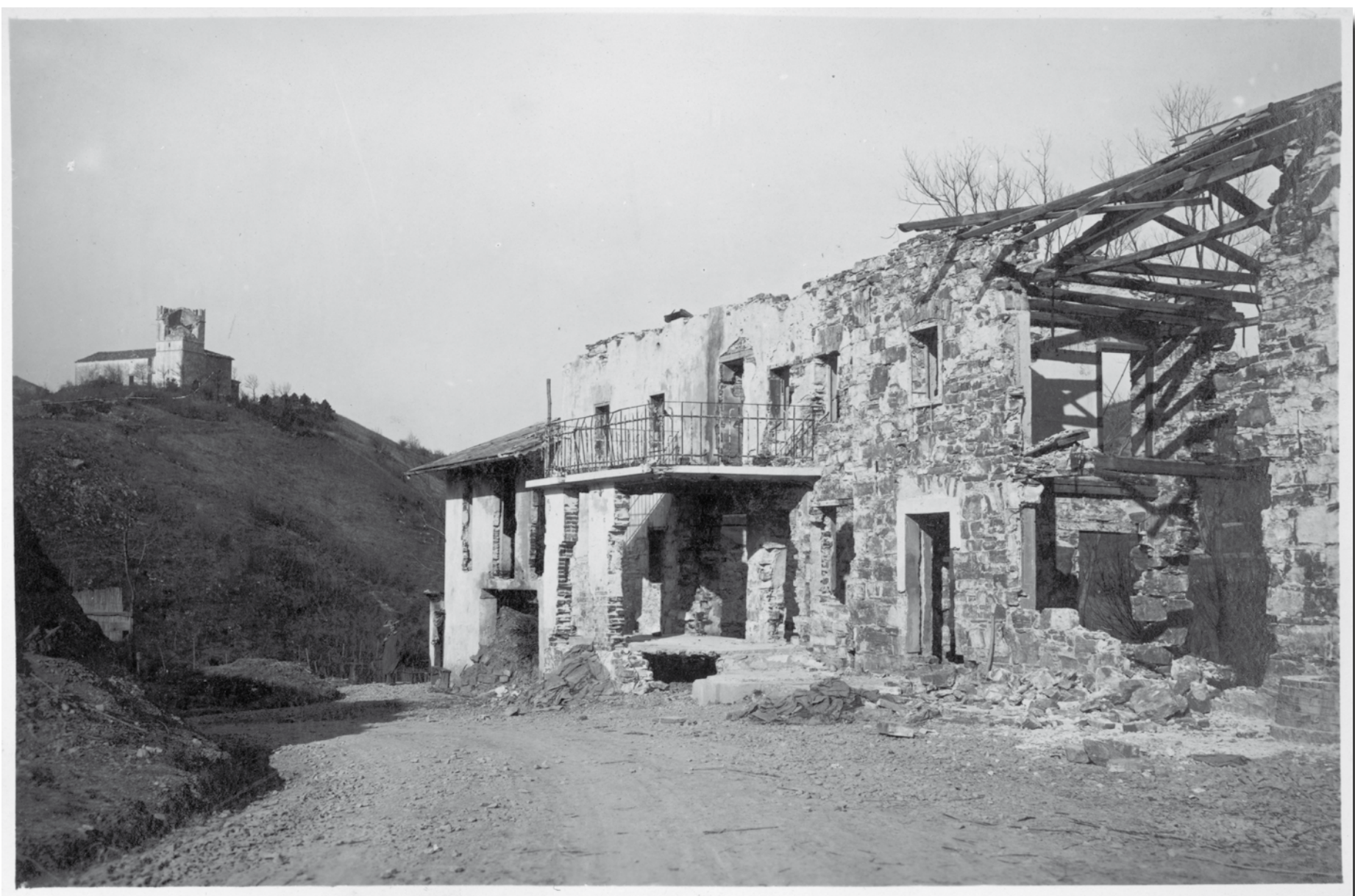
Vercoglia di Quisca (frazione di Còllio, Slovenia), settembre 1915. Una casa colonica distrutta dall'artiglieria nemica. Sulla collina, a sinistra, anche il campanile della chiesa reca visibili i danni causati dai proiettili. [PS3-263]
