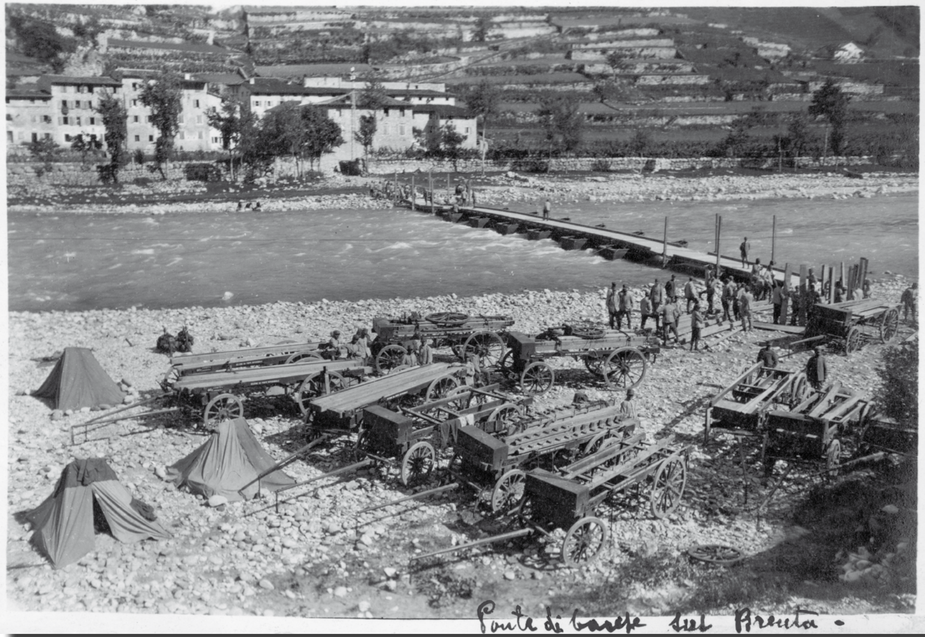
Fiume Brenta, maggio-giugno 1916. Battaglia degli Altipiani ( Strafexpedition ). Costruzione di un ponte di barche. [PS6-445]
