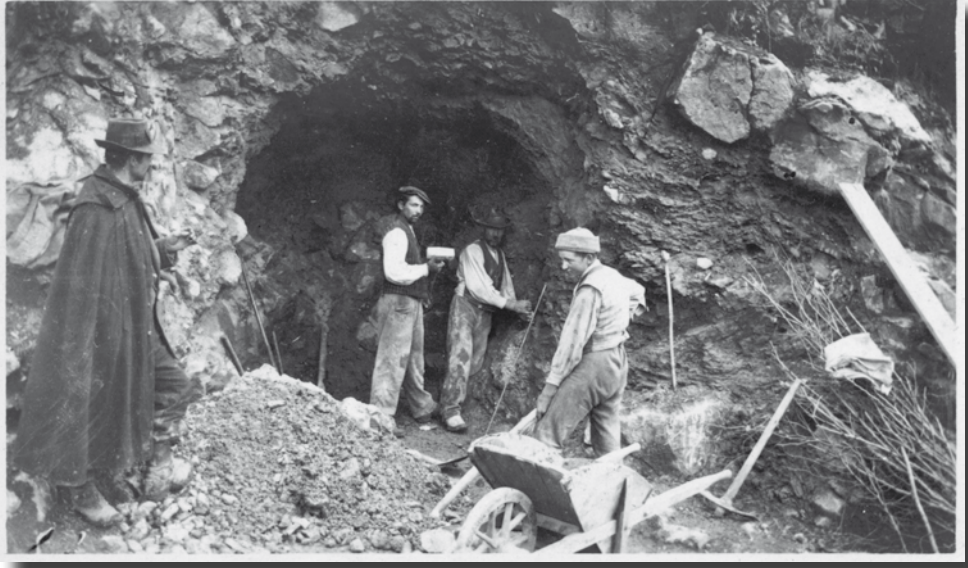
Autunno 1915. Edificazione di ricoveri e postazioni in pietra lungo una strada dell'alto Isonzo. [PS3-242; PS3-243]
